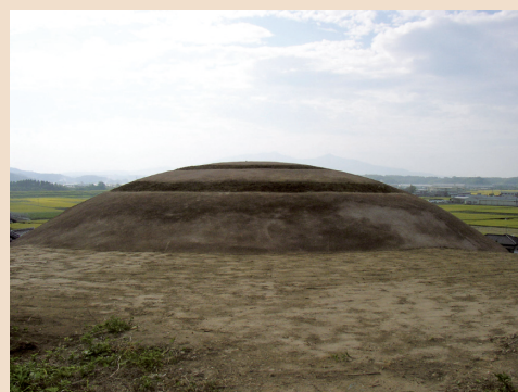
発泡スチロールドーム完成 2
