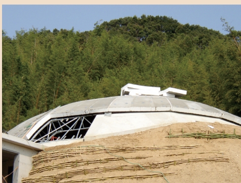
発泡スチロールドーム設置状況 5
