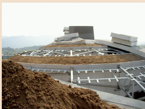
古墳基礎工事
